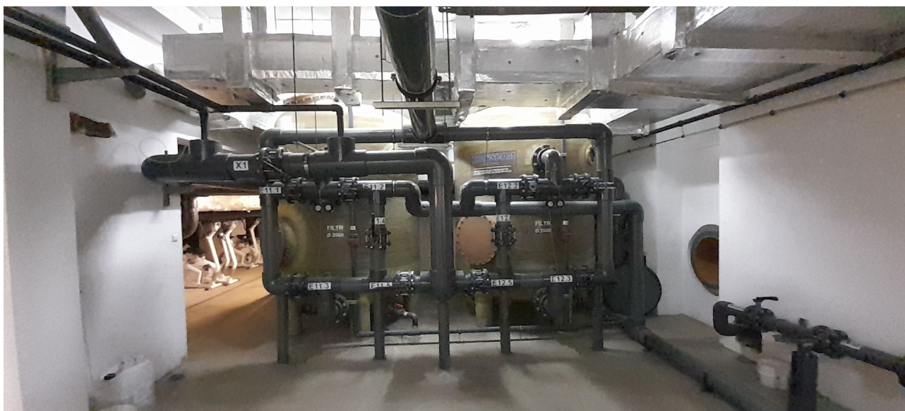
Pomieszczenie filtrów w podbaseniu - filtry
